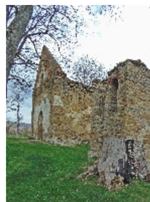
Ruiny cerkwi p. w. św. Paraskewy w Krywem
