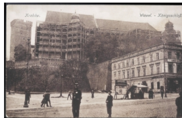
Wawel remont I w. św.
